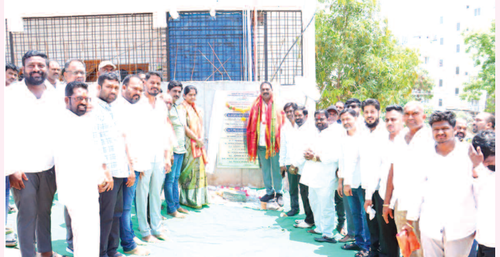
ఉప్పుర పల్లి లో సీన్ రోడ్డు పనులకు శంకుస్థాపన చేస్తున్న ఎమ్మెల్యే డి ప్రకాష్ గౌడ్, కార్పొరేటర్ పి అర్జున్ జయప్రకాష్, నాయకులు విజయ్ పాల్ రెడ్డి
