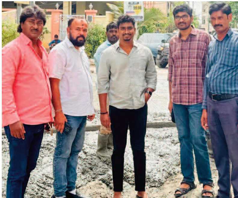
సీసీ రోడ్డు పనులను పరిశీలిస్తున్న అల్పాహార డివిజన్ కాంగ్రెస్ అధ్యక్షులు ప్రవీణ్ రెడ్డి
