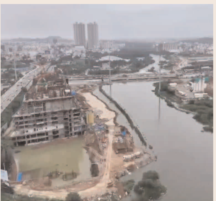
ఔటర్ రింగ్ రోడ్డు నార్కాంగ్రి చౌరస్తా వద్ద బఫర్ జోన్‌లో నిర్మిస్తున్న భారీ భవన నిర్మాణాలు
