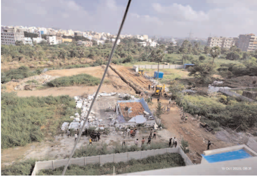
ఆక్రమ నిర్మాణాలను నేల మట్టం చేసిన హైద్రా అధికారులు
