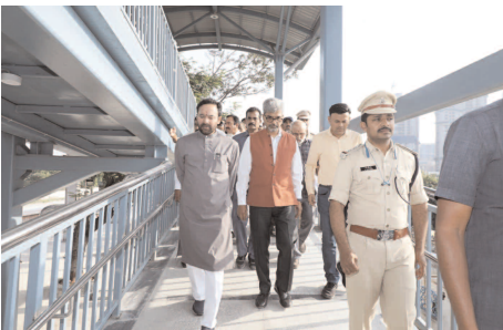
హైటెక్ సిటీ రైల్వే స్టేషన్ పనులు పరిశీలిస్తున్న కేంద్ర మంత్రి కిషన్ రెడ్డి ఇతర అధికారులు.
